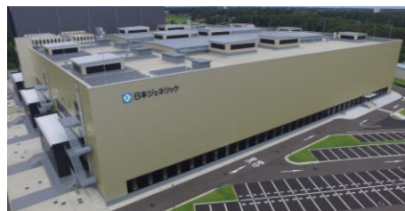
日本ジェネリック つくば第二工場
