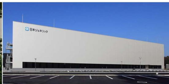
つくば第二工場
